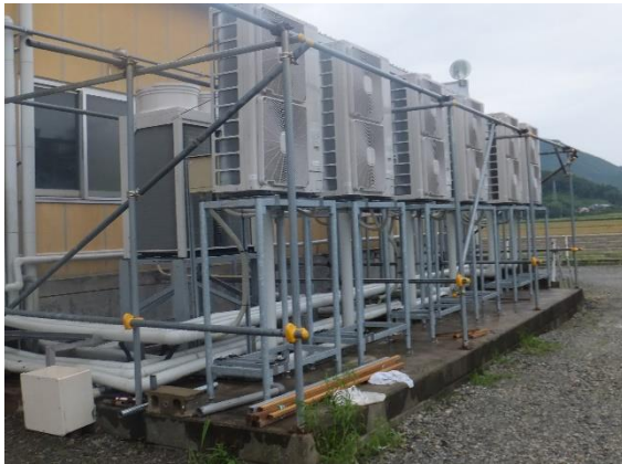
設備の嵩上げ
